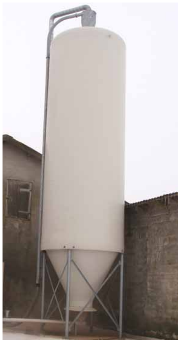
Strøelsesmaterialet blæses fra tankbilen op i en silo.
